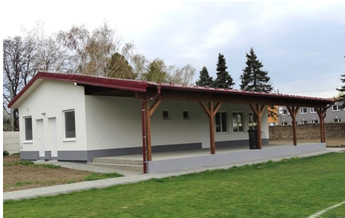
Rekonštrukcia kabín na futbalovom ihrisku (r. 2020 – 2022)
