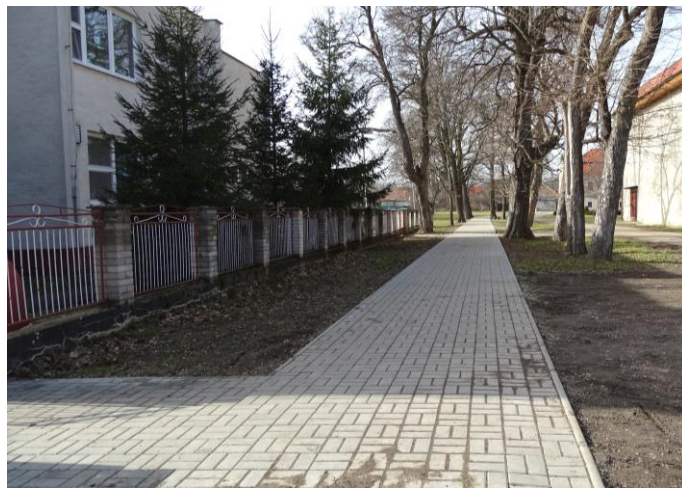
Rekonštrukcia chodníka pri materskej škole (r. 2020)
