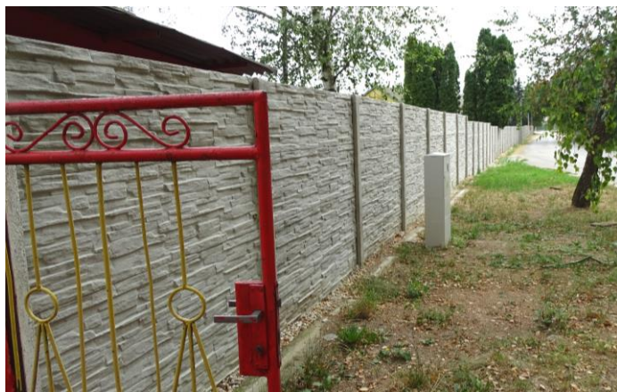
Vybudovanie nového oplotenia na futbalovom ihrisku (r. 2020)
