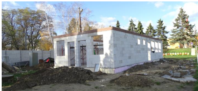
Výstavba šatní na ihrisku TJ
